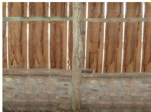
Figura 6: Estrutura das paredes do galpão.
