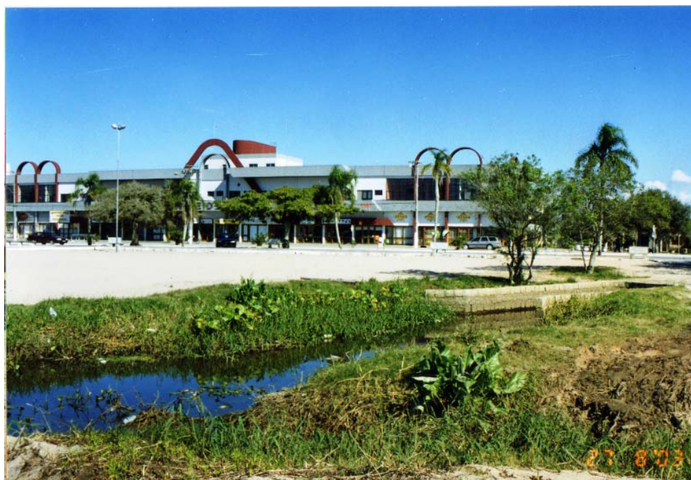
Figura 2- Estação de coleta Esgoto. Vala que drena o esgoto dos moradores e turistas da Praia do Laranjal e também a água da chuva. Foto: Marinês Garcia.
