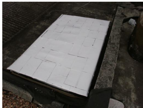
(b) vista dos painéis tetra pak já instalados
