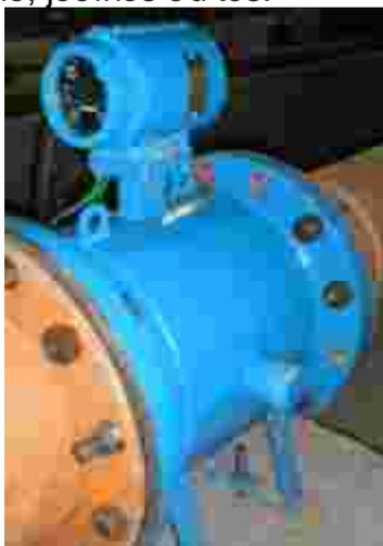
Figura 3 – Exemplo de medidor de vazão.
