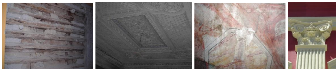
Figura 1: Estuque em prédios do Centro Histórico da cidade de Pelotas, RS. (a) Parede de estuque (Jóquei Clube de Pelotas); (b) forro de estuque com ornatos internos (Casarão 8);
