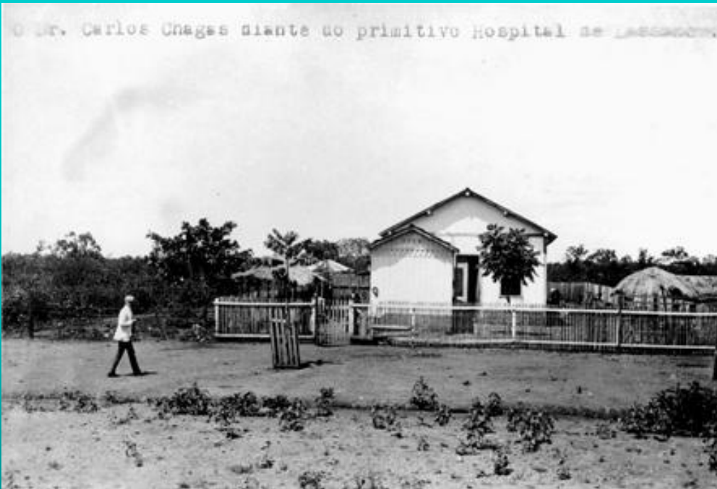
Hospital em Lassance - MG
